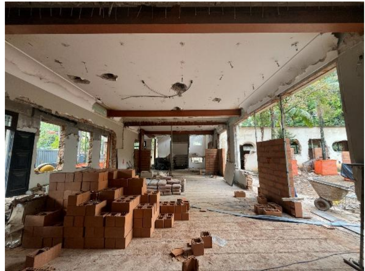
Fase – Alvenaria Interna
