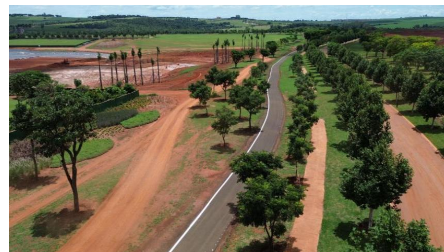
Imagem Aérea do Empreendimento 8
