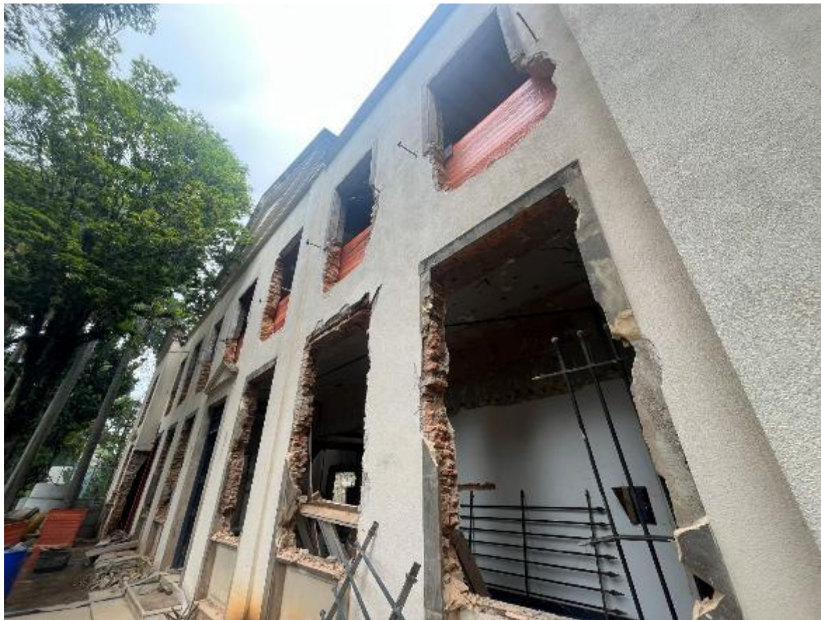
Demolições – Rua Alemanha
