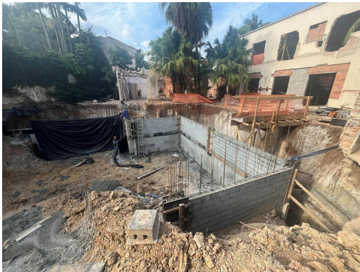
Fundação/Contenções – Rua Alemanha
